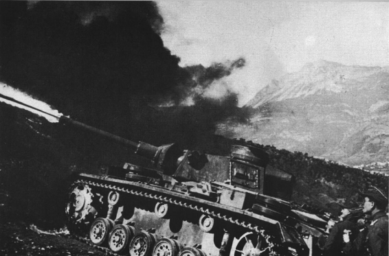
Hier führt man einen Flammpanzer III bei der 44. Infanteriedivision vor. Der Flammöl-vorrat von 1.020 Liter erlaubte die Abgabe von 80 Flammstößen mit je 2 bis 3 Sekunden Dauer. Allerdings erfüllten die Fahrzeuge die Erwartungen der Truppe nicht. Deshalb baute man bald (1943) einen Teil der Flammpanzer III wieder in normale Kampfpanzer um
