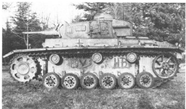
Oben links: Eine seltene Aufnahme! Panzer III/J mit der allgemein erst ab der Ausführung L und Panzer III mit der langen 5 cm KwK (L/60) üblichen Schottenpanzerung vor dem Turm und der Fahrerfront. Dazu noch die erst ab 1943 üblichen "Schürzen" um Turm und Wanne gegen Hohlladungsgeschosse. Hier Teile des Panzer-Regiments 1 (1. Panzer-Division).
