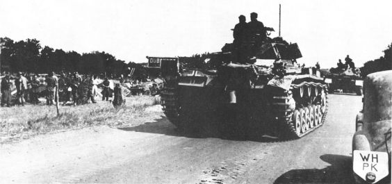
Ein Panzer III/F während des Frankreichfeldzuges. Der übliche Eimer am Heck, über dem Nebelabwurfgerät Zeltplanen, Ersatzkettenteile und Ersatzlauftrüder. Die zwei Striche am Turm sind interne Erkennungszeichen des Verbandes. Links ist eine Gefangenensammelstelle für französische Soldaten; interessant ist auch das weiße Schild am "Zivil" Pkw. Es heißt: Wehrmacht, Heer, Propaganda-Kompanie. Vermutlich ist es der Pkw des Fotografen dieses Bildes.
