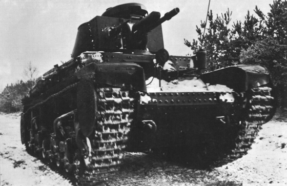
Der Winter 1939/40 wurde zu intensiver Ausbildung genutzt. Die Erfahrung des 1. Feldzuges mußte in die Truppe. Der ein wenig geöffnete Deckel des Turmausstieges war typisch für diesen Panzer, er erlaubte dem Kommandanten ein gutes Gesichtsfeld. Erst bei starker splitterhaltiger Luft wurde er geschlossen und mittels Optik und eines Handperiskops (hierfür gab es im Deckel eine Öffnung) das Gefechtsfeld beobachtet.
