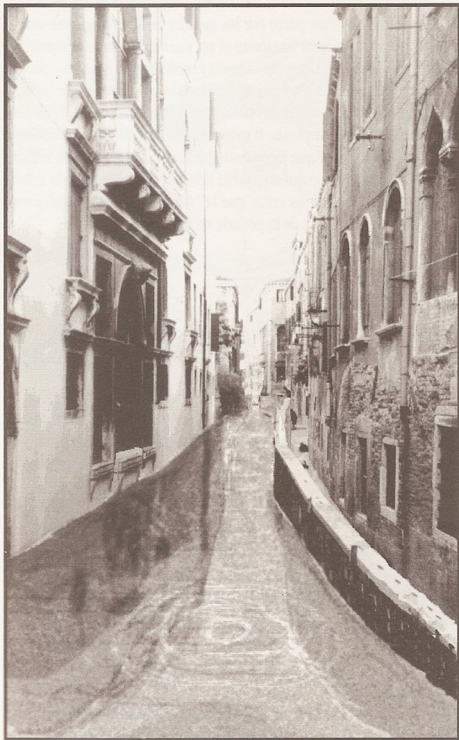
Ce muret, haut de deux mètres cinquante, s'abaisse d'un mètre en été. On remarquera la porte surélevée, à gauche et le pont coupé, au fond.
